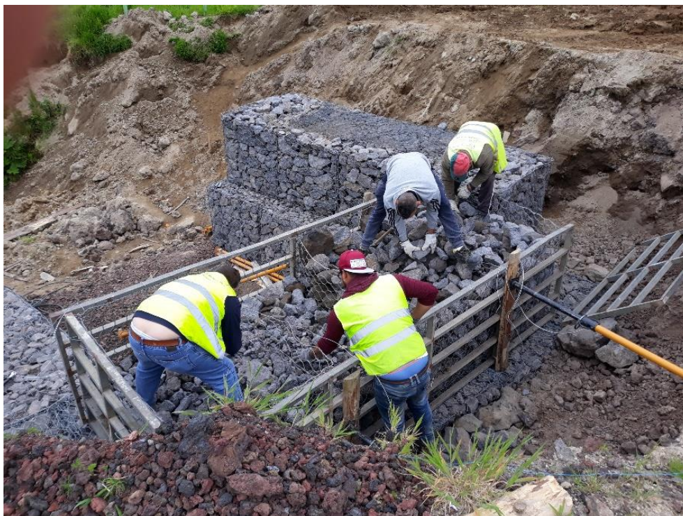
Fotografia 1: Muro de gabiões
