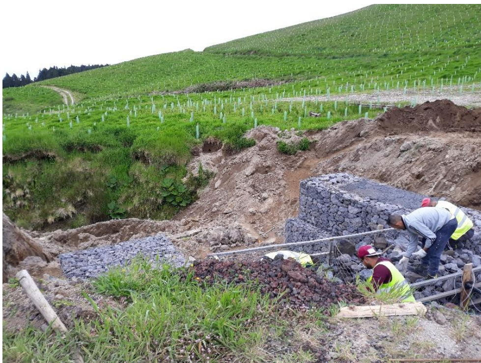
Fotografia 2: Muro de gabiões
