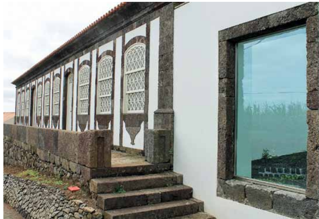
Figura 46. "Solar dos Tiagos" depois de reabilitado, no Topo
