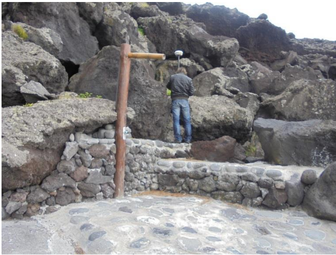
Figura 14. Melhoramentos na Zona Balnear 06 Moinhos (Urzelina), Parte 1
