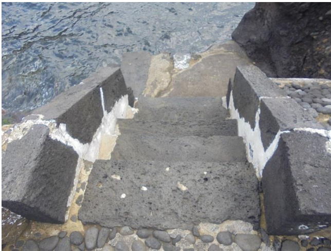
Figura 15. Melhoramentos na Zona Balnear 06 Moinhos (Urzelina), Parte 2
