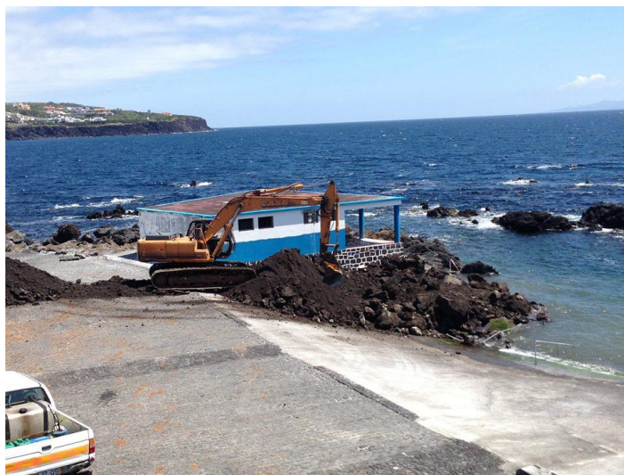
Figura 3. Obras a decorrerem na Poça dos Frades em 2014
