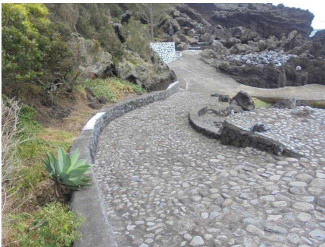
Figura 16. Melhoramentos na Zona Balnear 06 Moinhos (Urzelina), Parte 3
