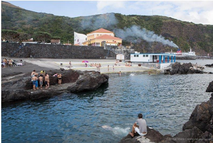
Figura 4. Zona Balnear Poça dos Frades após as obras de requalificação
