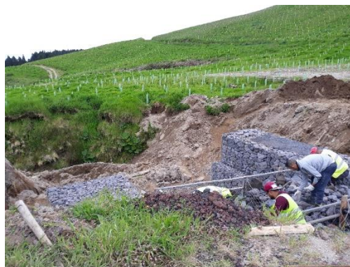
Fotografia 9: Muro de gabiões
