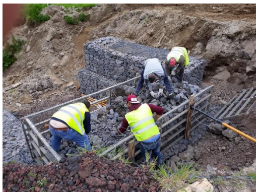
Fotografia 8: Muro de gabiões
