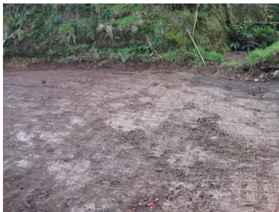
Fotografia 5: Estrutura de drenagem da água
