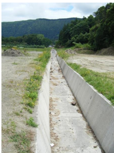
Figura 7.2.3 – Vala de drenagem de águas pluviais da Rua das Praias que atravessa os terrenos do parque de campismo das Sete Cidades - 2009
