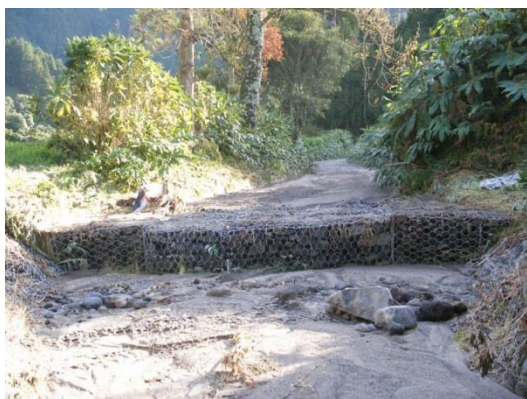
Figura 7.2.2 – Exemplo de açude construído na Grota do Inferno - 2009
