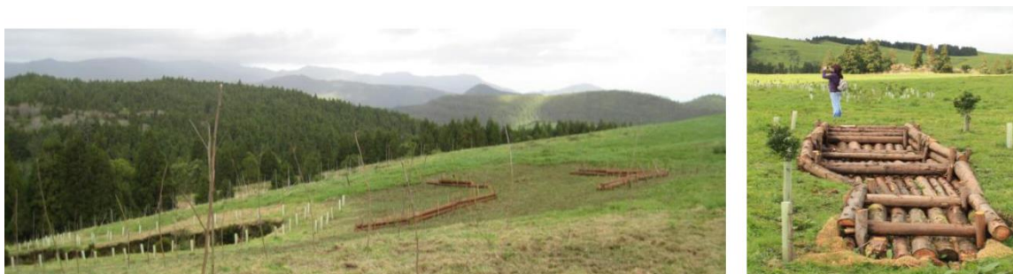
Figura 7.3.2.4 - Dissipadores de energia (2012)
