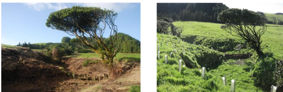
Figura 7.3.2.3 - Linha de erosão intervencionada. Durante a intervenção e após a intervenção (2012)
