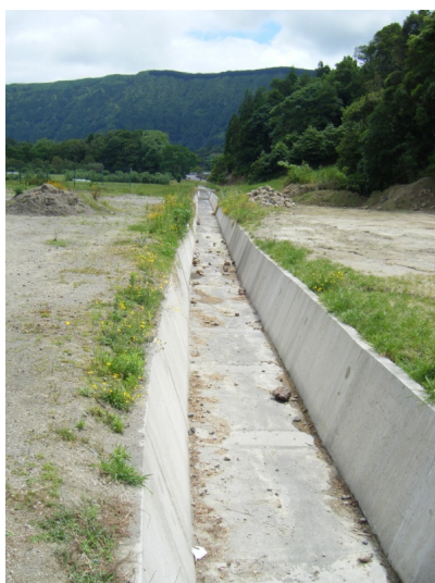
Figura 6.2.3 – Vala de drenagem de águas pluviais da Rua das Praias que atravessa os terrenos do parque de campismo das Sete Cidades
