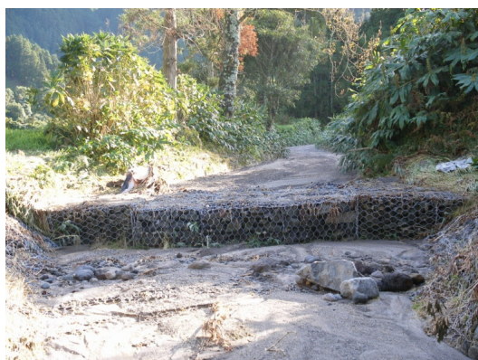
Figura 6.2.2 – Exemplo de açude construído na Grota do Inferno
